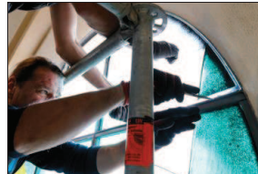
Il a fallu une dizaine de jours à Christophe Berthier et ses équipes pour installer six vitraux. Chacun est composé de 24 éléments de 80x60 cm. « Un vitrail pèse, au final, 1,2 tonne », note le maître verrier.
