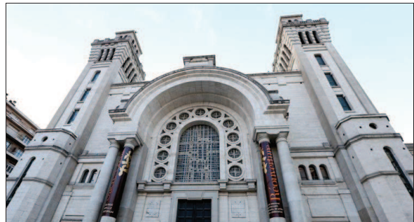
Il a fallu une dizaine de jours à Christophe Berthier et ses équipes pour installer six vitraux. Chacun est composé de 24 éléments de 80x60 cm. « Un vitrail pèse, au final, 1,2 tonne », note le maître verrier.
