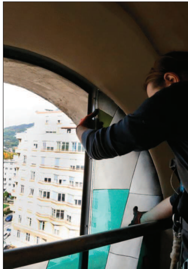
Il a fallu une dizaine de jours à Christophe Berthier et ses équipes pour installer six vitraux. Chacun est composé de 24 éléments de 80x60 cm. « Un vitrail pèse, au final, 1,2 tonne », note le maître verrier.
